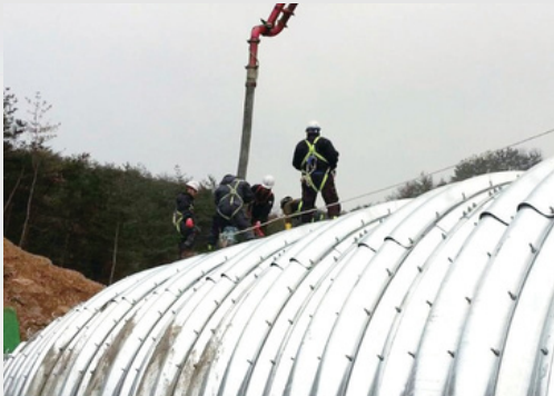
시공 중 (보강 콘크리트타설)
