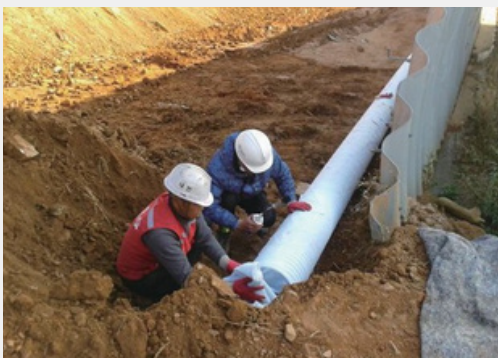
시공 중 (배수 처리)
